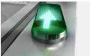
Auf der Außenabdeckung der Balustrade
