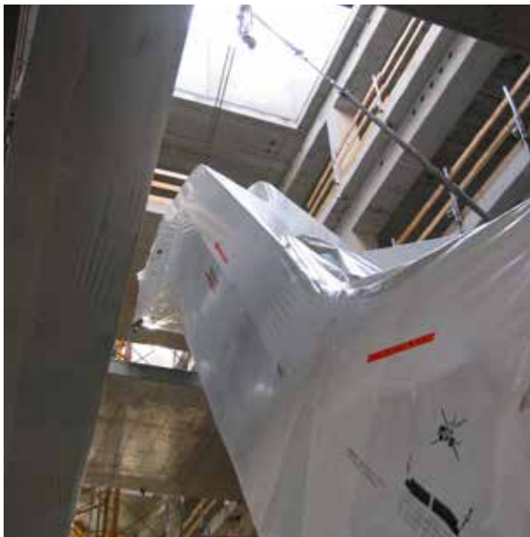
Montage der Anlage in einem Stück mittels Kran
